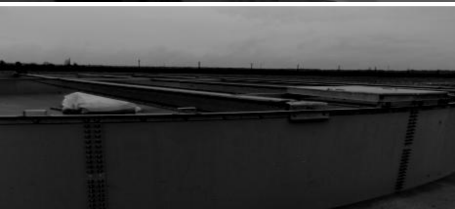
3. 1 ère virole +structure du toit assemblés
