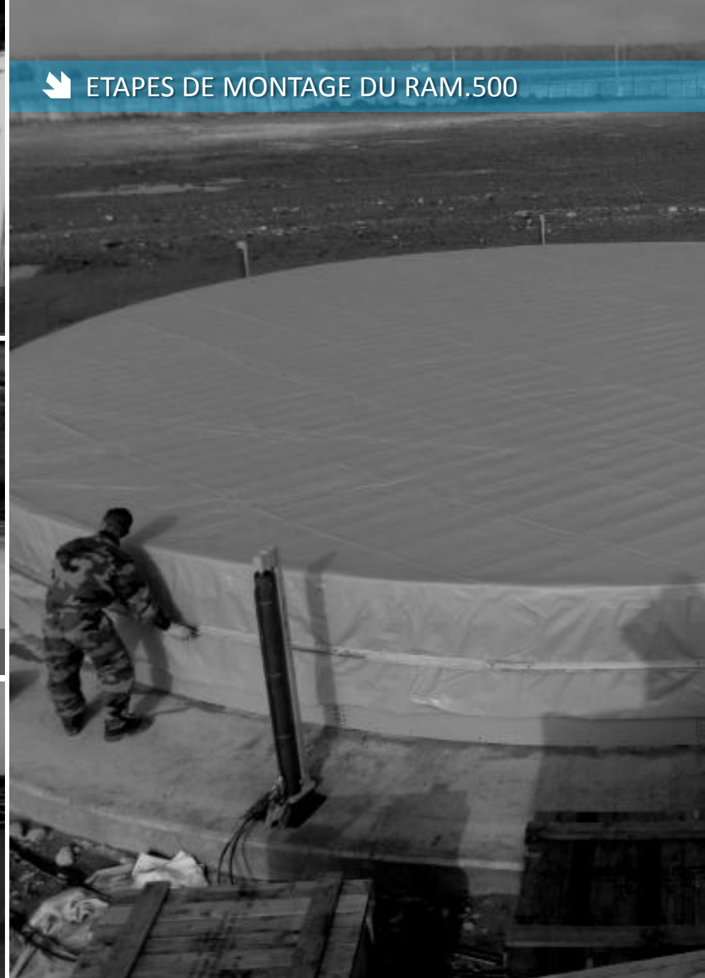
4. Couverture de toit montée + positionnement des vérins
